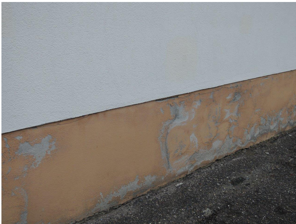
Foto č. 2 - Pohled západní – trhlina, povrchová plíseň
