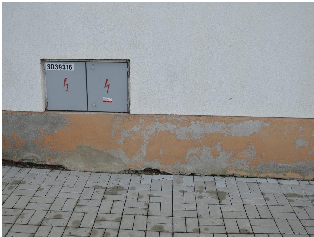
Foto č. 1 - Pohled západní – trhlina, opadaná omítka
